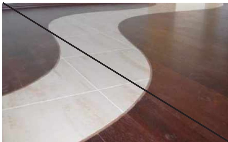
Плохо Узорные стыки из разных материалов
