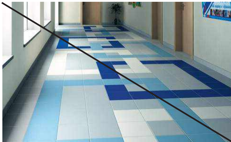
Плохо Цветные вставки из плитки
